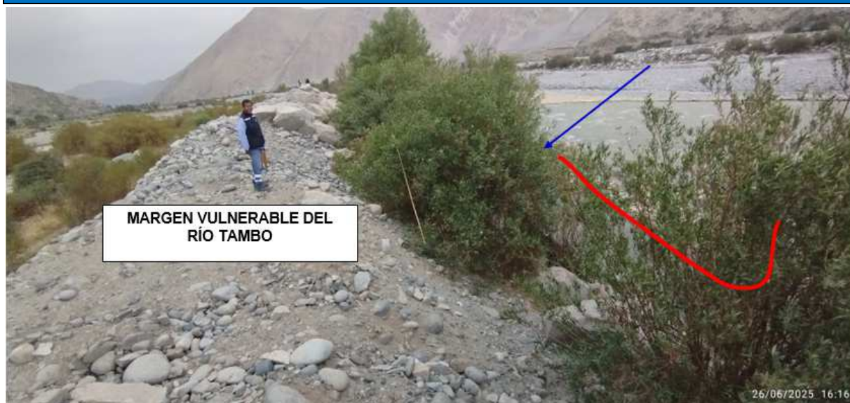
FIGURA N°01: TRAMO 01 INICIO DE ACTIVIDADES, TRAMO DE DIQUE SIN ENROCADO DE PROTECCION
